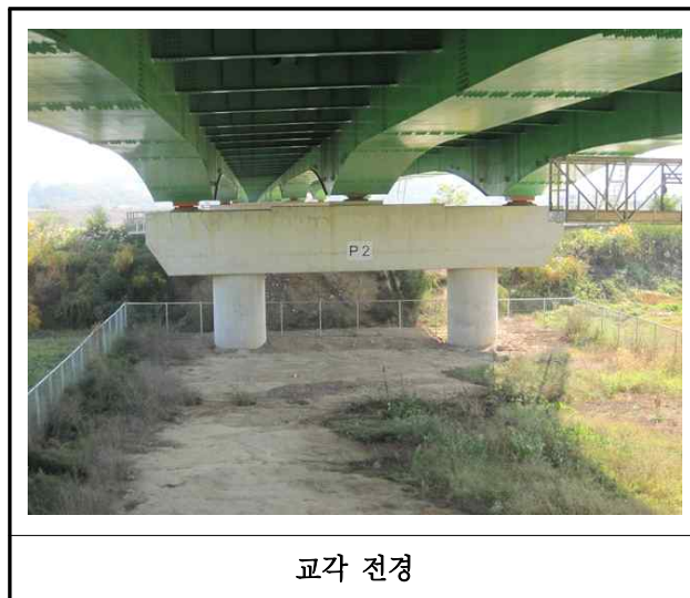
【사진 5.3.10】 교각 전경
