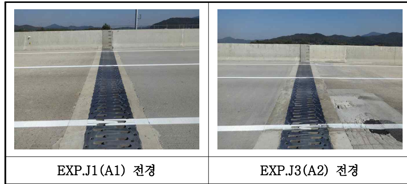
【사진 5.3.16】 신축이음장치 전경
