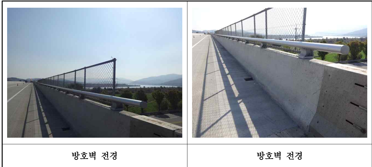
【사진 5.3.23】 방호벽 및 중앙분리대 전경
