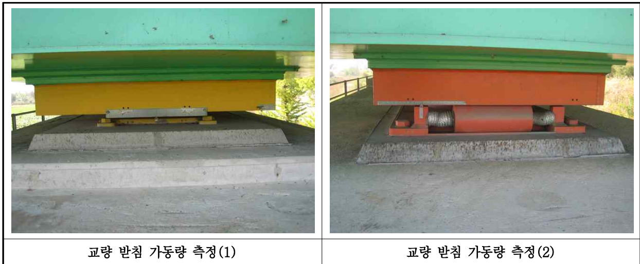
【사진 5.3.15】 교량받침 이동량 측정
