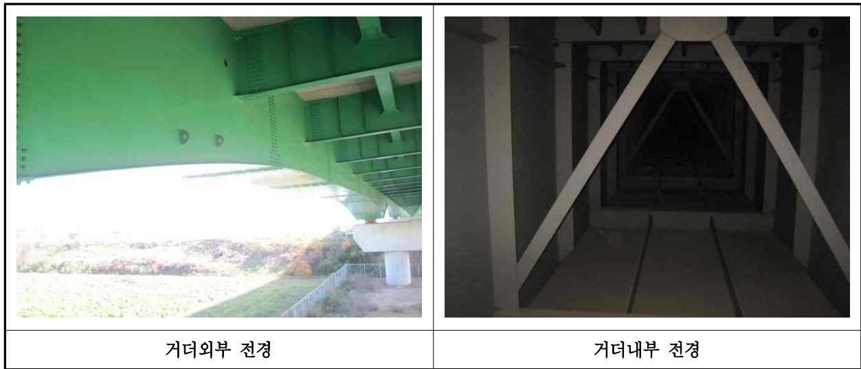
【사진 5.3.4】 거더 전경
