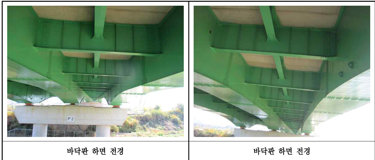
【사진 5.3.2】 바닥판하면 전경
