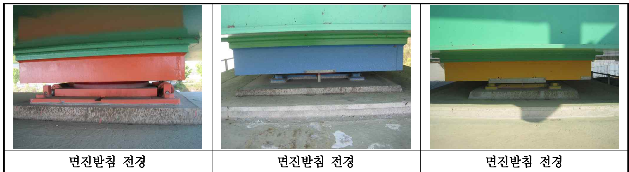
【사진 5.3.12】 교량받침 전경
