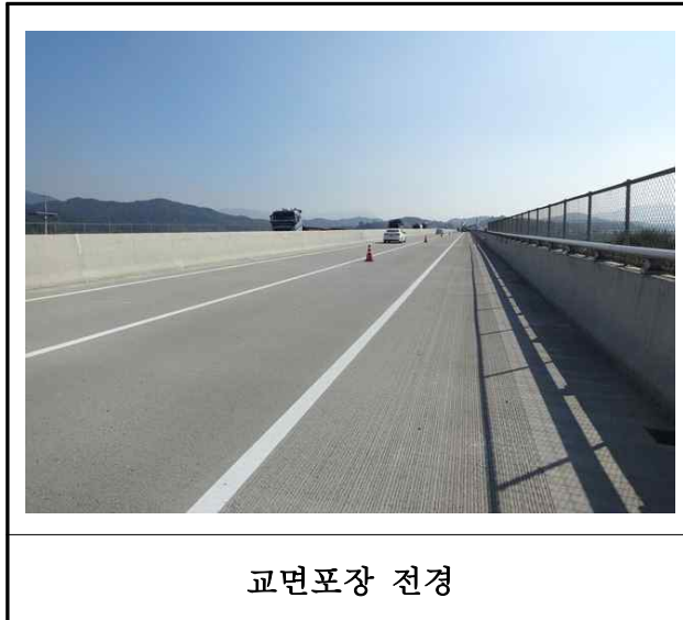
【사진 5.3.19】 교면포장 전경
