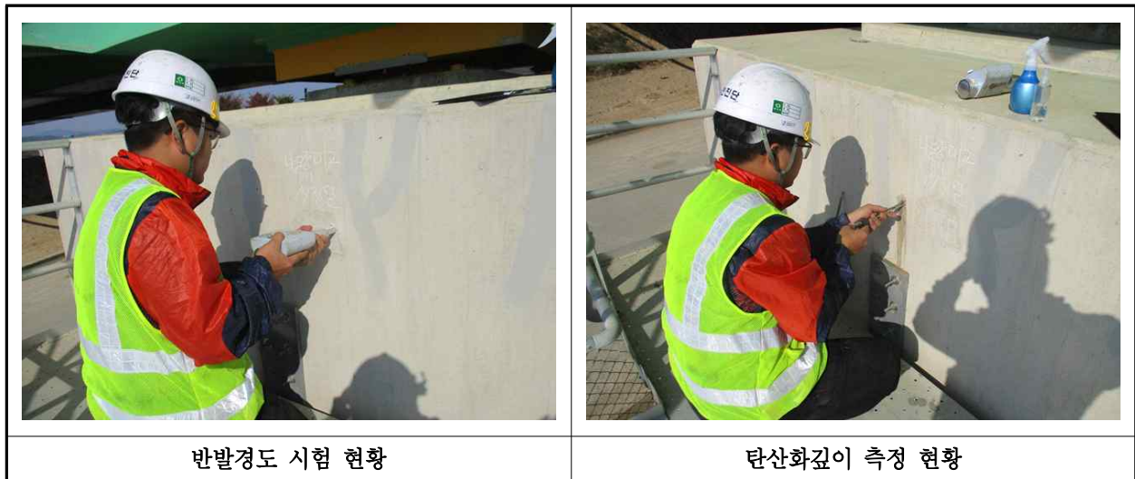
【사진 5.4.1】 콘크리트 내구성조사 현황
